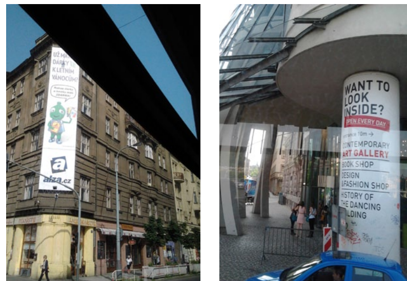
Obr. 27, 28 Na první fotografii překrývá reklama na alza.cz – „Už máte dárek k letním Vánocům“ – značnou plochu fasády. Uvedený text reklamy mohou zkusit žáci parodovat – nabízí se odpověď: „... nemáme, čekáme na zimní Velikonoce...“ Na druhé fotografii je pro reklamu využit architektonický prvek Tančícího domu.
